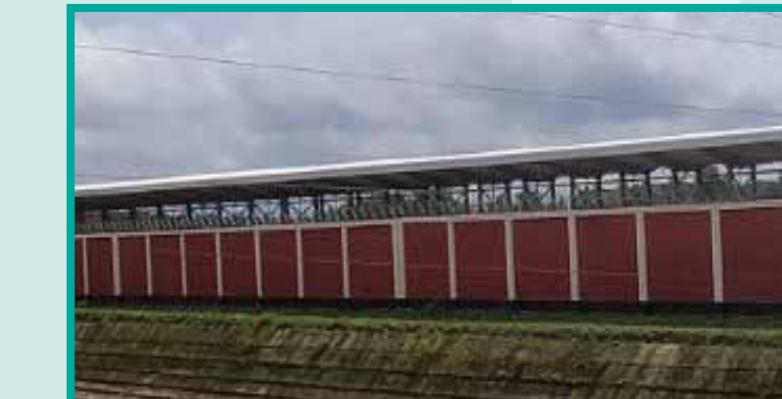
শেওলা স্থলবন্দরে নির্মিত বাউন্ডারি ওয়াল।
