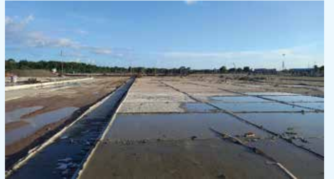
বালা স্থলবন্দরের ইয়ার্ড নির্মাণ
